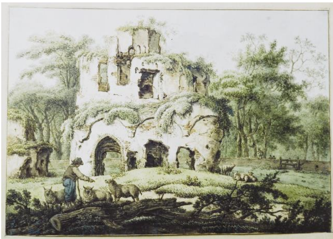
Barend Hendrik Thier, Ruïne van de Abdij te Rijnsburg, vanuit het oosten , ca. 1800 (Bron: privé-collectie)
